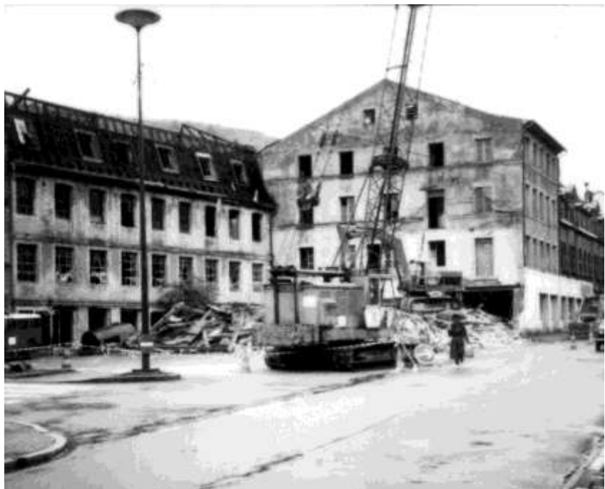
15 Démolition de l'usine Bernard Meier, place Prensureau à Sainte-Marie-aux-Mines en 1986 – Coll. José Antenat
