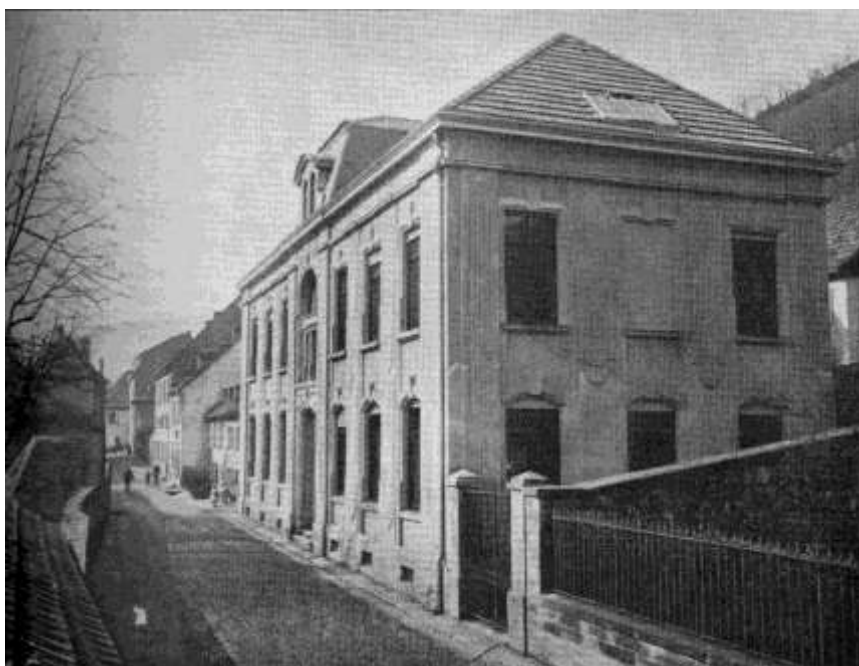
16 Bâtiment de la Société Industrielle de Sainte-Marie-aux-Mines. Photo parue dans le Messenger des Vosges illustré du 8 Mai 1904, N°10 – Bib SIC / Médiathèque du Val d'Argent
