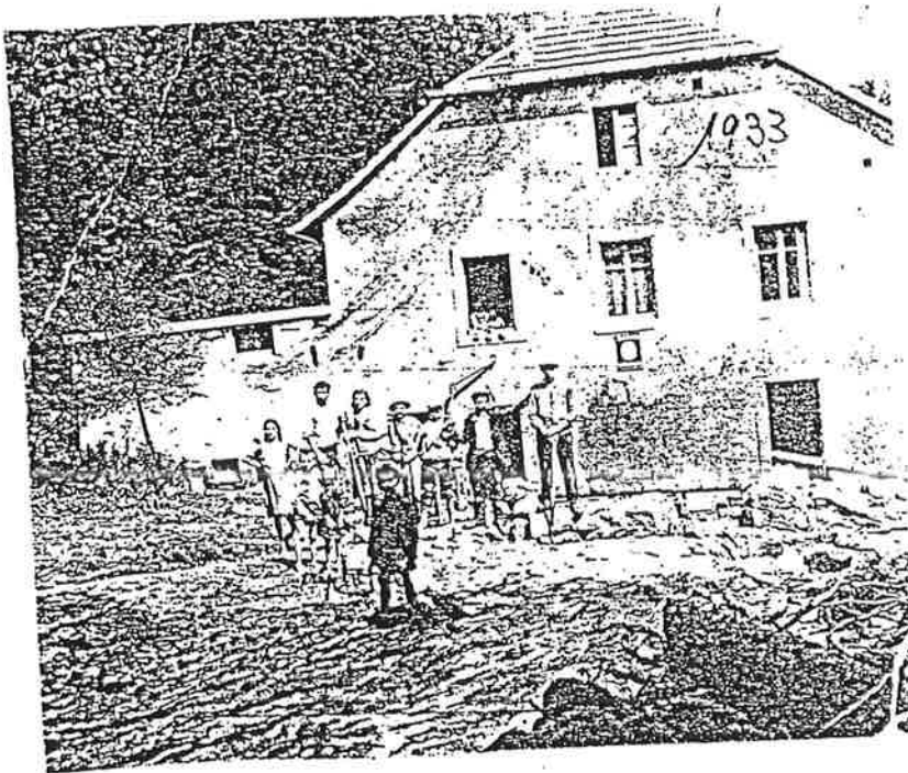
D'importants dégâts devant la ferme de Votembach. Une bille de bois traverse la maison.
